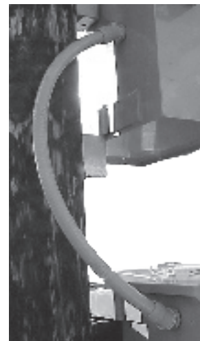
Fig. 2-12, Conduit in Place
